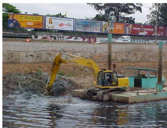
Figura 6-3: Dragagem de Mandíbula operando no rio Tietê em 2008
